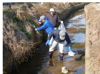
(水路内の清掃)
