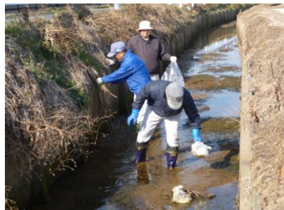
(水路内の清掃)
